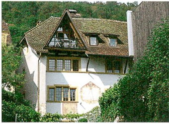
9 Bienne, route de Neuchâtel 48
