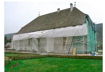
19 Courtelary, rue de la Préfecture 2
