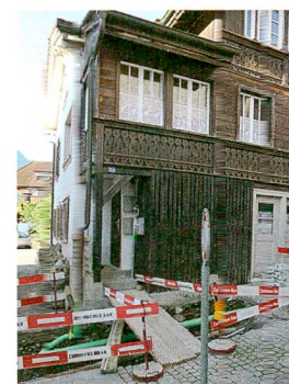
108 Unterseen, Obere Gasse 44
