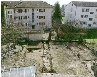
61 Nidau, Mittelstrasse 15a
