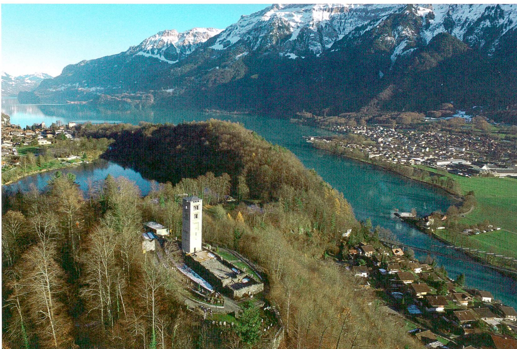
Abb. 10: Die Kirchenruine von Goldswil in der Gemeinde Ringgenberg wurde im Zuge der Sanierung archäologisch untersucht.
