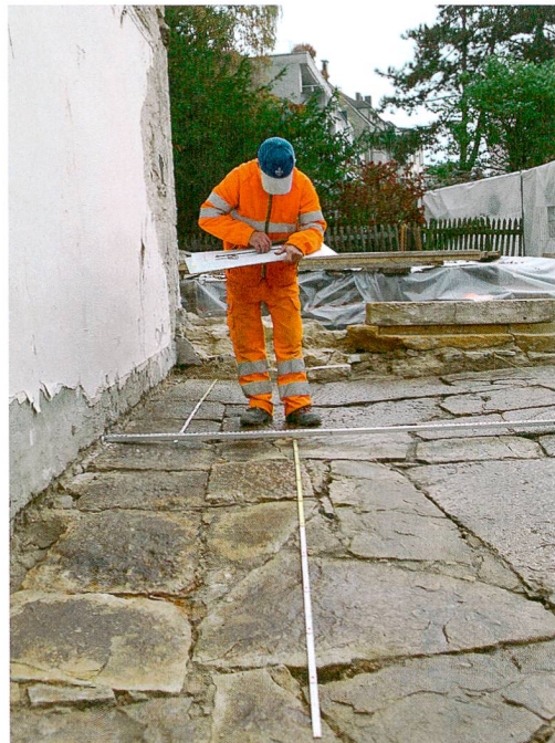
Fig. 4 : Bienne, rue Karl-Neuhaus 3. Relevé du dallage calcaire apparu au niveau de l'annexe sud, érigée après 1846 et démolie en 2016.
