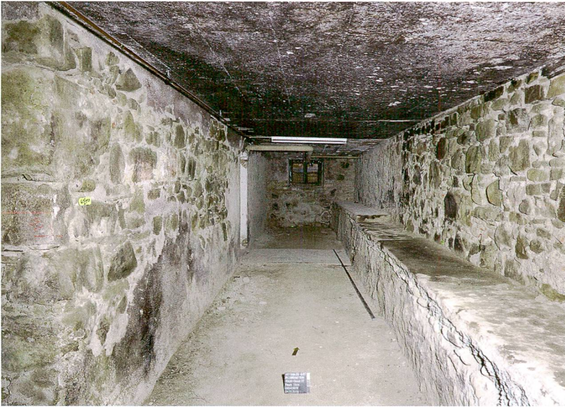
Abb. 3: Blumenstein, Badstrasse 37. Am linken Bildrand ist die Aussen-mauer des ältesten Kellers aus der Zeit um 1600 ersichtlich. Rechts der Unterbau der Veranda von 1879. Der lange, schmale Gang wurde erst nach den Umbauten im Jahr 1932 erschlossen. Blick nach Norden.
