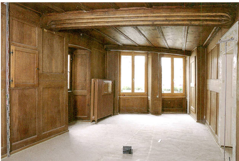
Fig. 7: La Neuveville, Grand Rue 15. Bâtiment B, 1 er étage. Belle pièce richement boisée comportant un plafond et des solives ouvragées du 16 e siècle, ainsi qu'une poutre en chêne du 18 e siècle.
