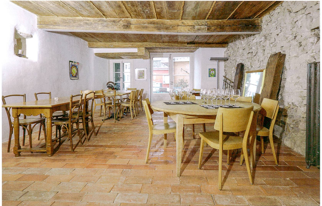
Fig. 5: La Neuveville, Grand Rue 15. Bâtiment A, 1 er étage. Le sol en brique, restauré à l'identique, repose sur un solivage en madriers du 16 e siècle; le plafond est de la même époque.
