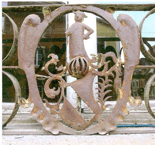
Fig. 6: La Neuveville, Grand Rue 15. Un des deux garde-corps extérieurs encore conservés au 1 er étage. On devine, inscrite dans un médaillon, la silhouette d'un homme coiffé d'un tricorne et portant un manteau, juché sur un écusson casqué.
