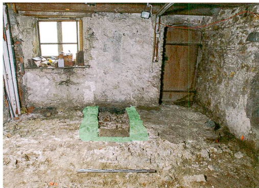
Abb. 5: Twann-Tüscherz, Dorfgasse 9c. Erdgeschoss mit Kachelofenfundament (grün). Rechts, die ursprüngliche Tür; links, das Doppelfenster aus dem späten 17. Jahrhundert.
