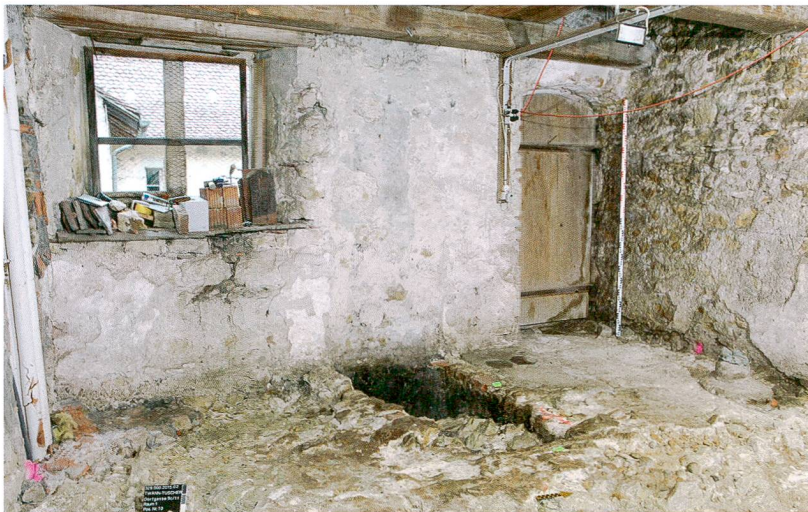
Fig. 3 : Twann-Tüscherz, Dorfstrasse 9c. Au rez-de-chaussée, le poêle était adossé au mur gouttereau ouest et reposait sur la voûte de la cave.
