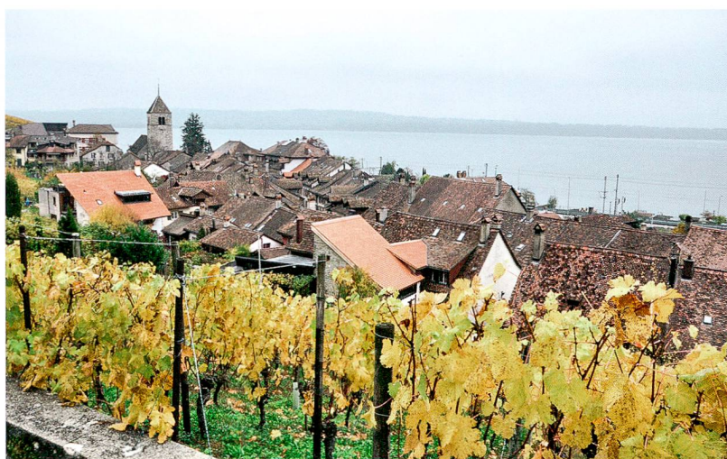
Fig. 1 : Twann-Tüscherz, Dorfgasse 9c. Le bâtiment se trouve au centre de l'image, avec sa toiture à pan unique toute neuve. Vue vers le sud-est.
