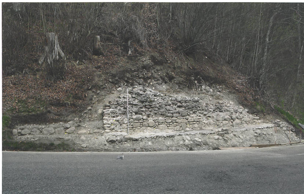
Abb. 1: Aeschi bei Spiez. Ruine der ehemaligen Kapelle Mülönen nach der Freilegung im Sommer 2016. Blick nach Norden.
