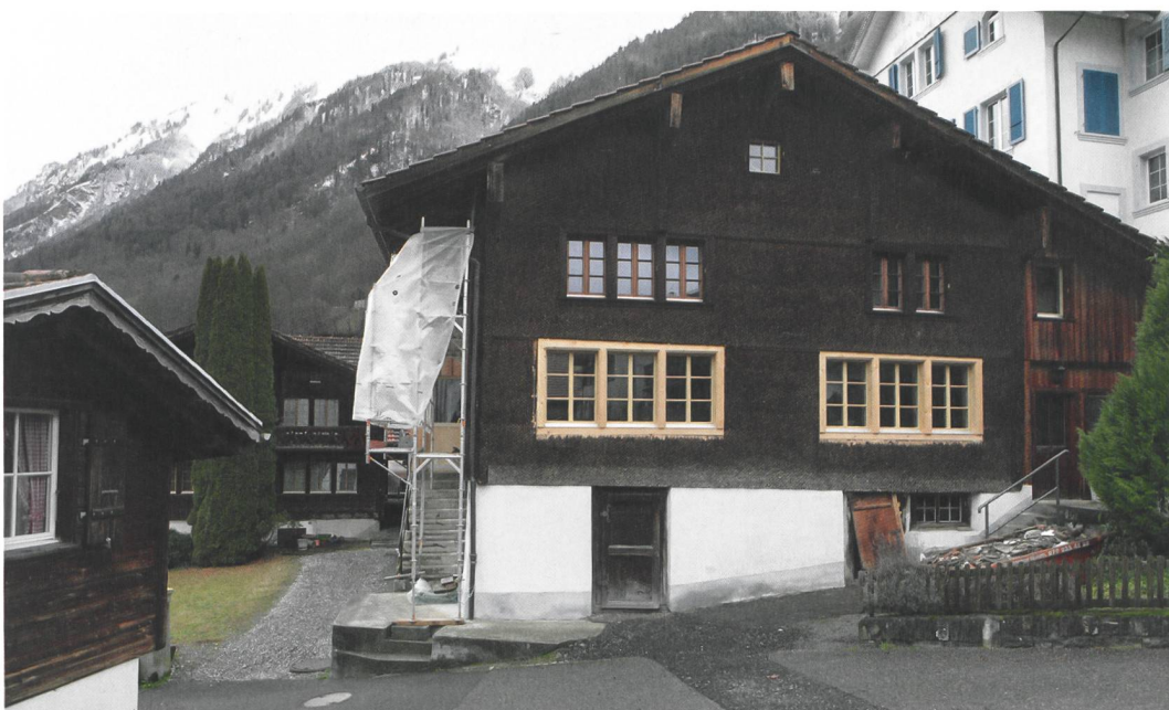
Abb. 1: Oberried, Untergasse 9. Hinter der verschindelten Fassade schlummerte unerkannt ein altes Haus. Blick nach Westen.
