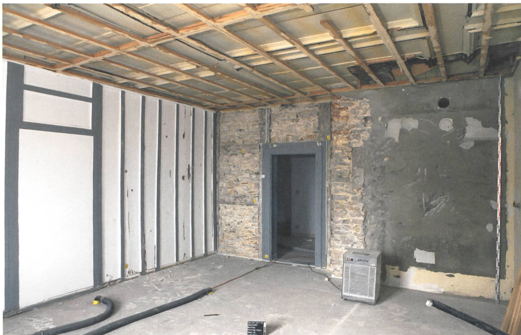
Fig. 7 : Saicourt, Bellelay, L'Abbaye 1. 2 ème étage : la Salle de justice et son plafond à caissons ; à droite, dans le plafond, traces du fourneau rectangulaire aujourd'hui disparu. La paroi en bois, à gauche, est postérieure et date probablement de la seconde moitié du 18 e siècle. Vue vers l'est.
