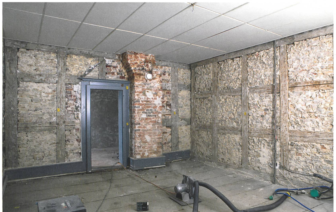
Fig. 6 : Saicourt, Bellelay, L'Abbaye 1. Au 2 ème étage, les murs porteurs sont réalisés en pan de bois hordé. Dans la pièce nord-est, l'agrandissement du canal de fumée entraîna le déplacement de la porte. Vue vers le sud.
