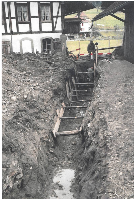
Abb. 3: Krauchthal, Hettiswil, Oele 1–3. Kanal- graben zwischen Wohn- haus (rechts) und Stöckli (links), 1969/70. Blick nach Osten.
