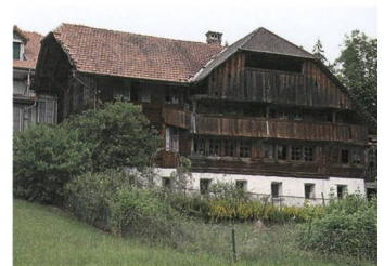
24 Buchholterberg, Rohrimoosstrasse 6a/6b
