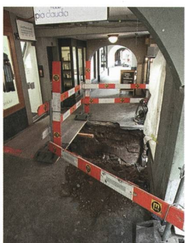
15 Bern, Rathausgasse, Leitungserneuerungen
