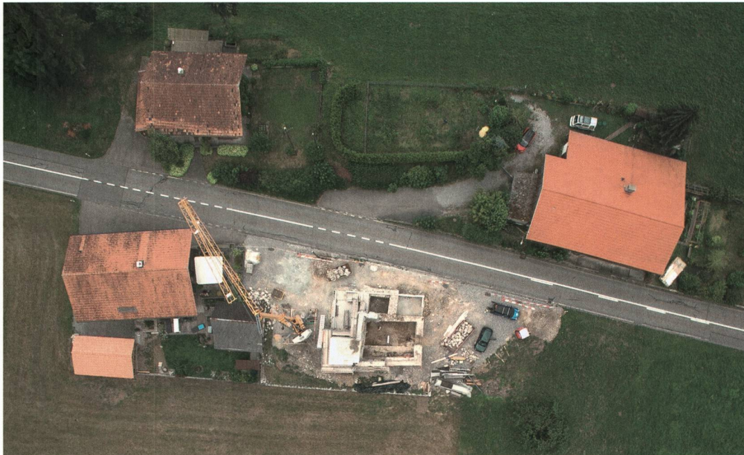
Abb. 3: Stocken-Höfen, Stockentalstrasse 33. Drohnfoto der Baustelle mit der Stockentalstrasse und den drei benachbarten Liegenschaften im Juli 2018. Aus der Vogelperspektive zeichnen sich die Grundrisse von Chor und Turm der Kapelle deutlich ab.
