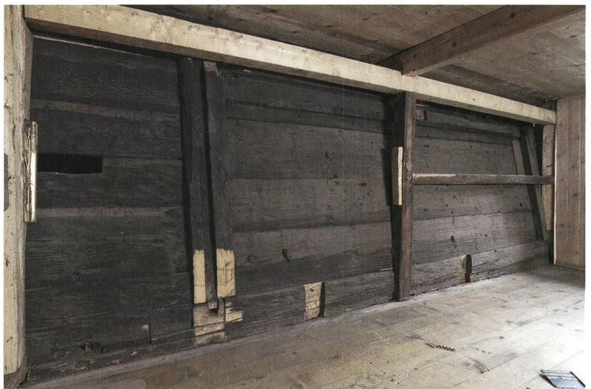
Abb. 18: Stocken-Höfen, Stockentalstrasse 33. Nördliche Gadenwand im Obergeschoss des Wohnhauses nach dem Entfernen des Täfers im Februar 2018. Blick nach Nordosten.
