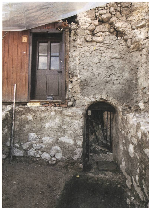
Abb. 14: Stocken-Höfen, Stockentalstrasse 33. Das Erdgeschoss des Glockenturms der Kapelle mit dem wieder geöffneten Zugang in der nördlichen Chormauer und darüber der Haustüre des späteren Wohngebäudes nach der Freilegung im April 2018. Blick nach Süden.
