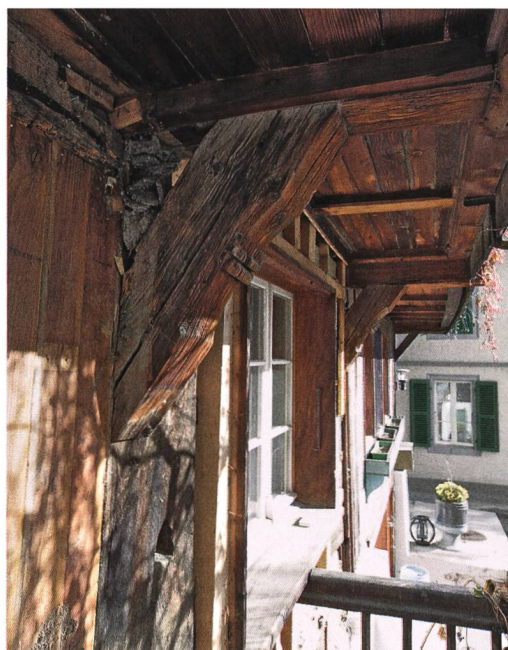
Abb. 6: Steffisburg, Schulgässli 26. Profilerter Bug der unteren Frontlaube vermutlich des Ursprungsbaus von 1569. Sie wurde beim Stubenumbau im 17. Jahrhundert neu an der jetzigen Stelle eingebaut.
