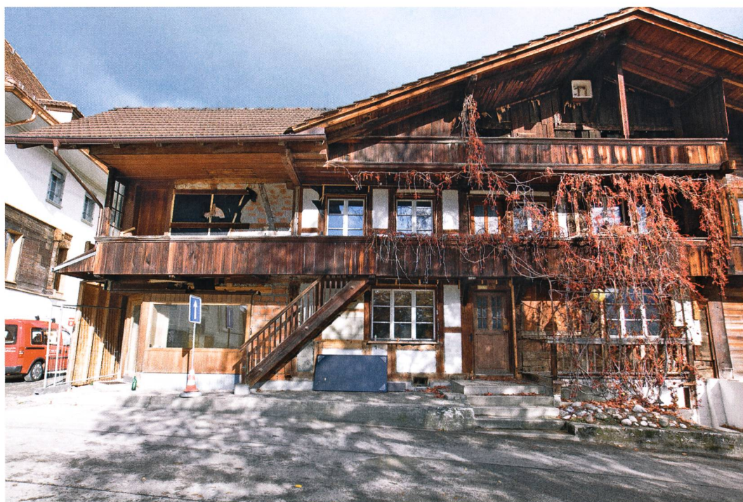
Abb. 1: Steffisburg, Schulgässli 24/26. Ausschnitt der zum Schulgässli ausgerichteten Südfassade. Zu sehen ist der untersuchte westliche Hausteil.
