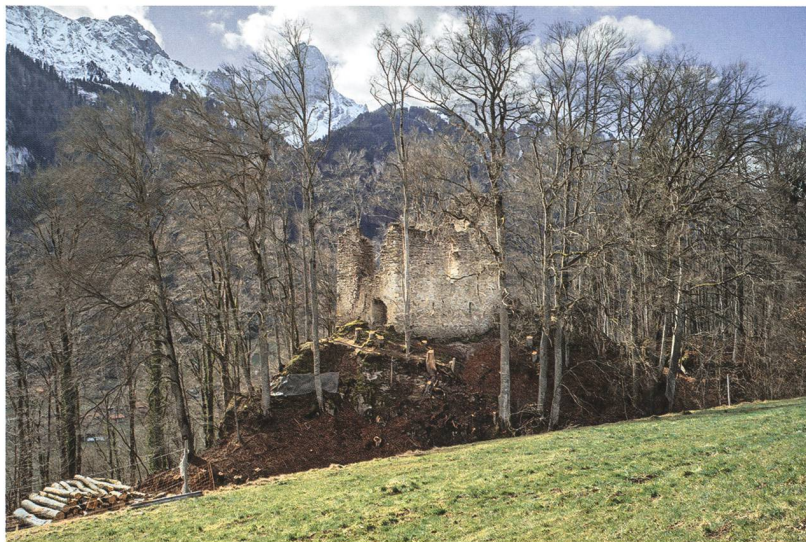
Abb. 8: Die Burgruine Jagdburg in Stocken-Höfen wurde bauarchäologisch untersucht und in einer ersten Etappe saniert.
