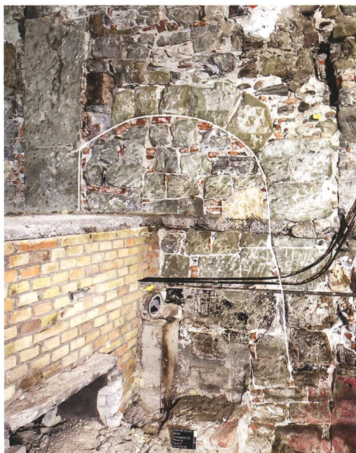
Abb. 7: Bern, Kramgasse 72 / Rathausgasse 61. Durchgang 84 (weisse Linie) in der westlichen Brandmauer auf der Seite Kramgasse, zwischen Parzelle E und der mutmasslichen Hofzufahrt beziehungsweise Quergasse.
