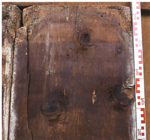
Fig. 8 : La Neuveville, rue du Collège 5. Madrier découvert en emploi dans le sol de la cuisine du 1 er étage. Daté de 1507 par la dendrochronologie, il appartenait au plafond-plancher du 2 e étage.
