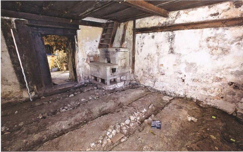
Fig. 4 : Petit-Val, Souboz, Haut du Village 37. Séjour. Négatifs de solives, fourneau en molasse de 1904 et escalier accédant à la pièce de nuit. À droite, on devine les maigres vestiges de lambris encore conservés.
