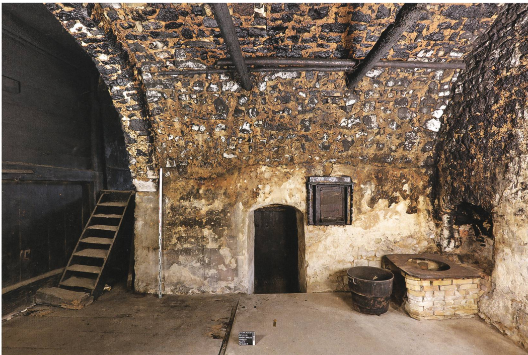
Fig. 3 : Petit-Val, Souboz, Haut du Village 37. Mur nord de la cuisine voûtée. À gauche, on distingue l'escalier accédant à la chambre nord, au centre la porte de cave et à droite la chaudière moderne en briques.
