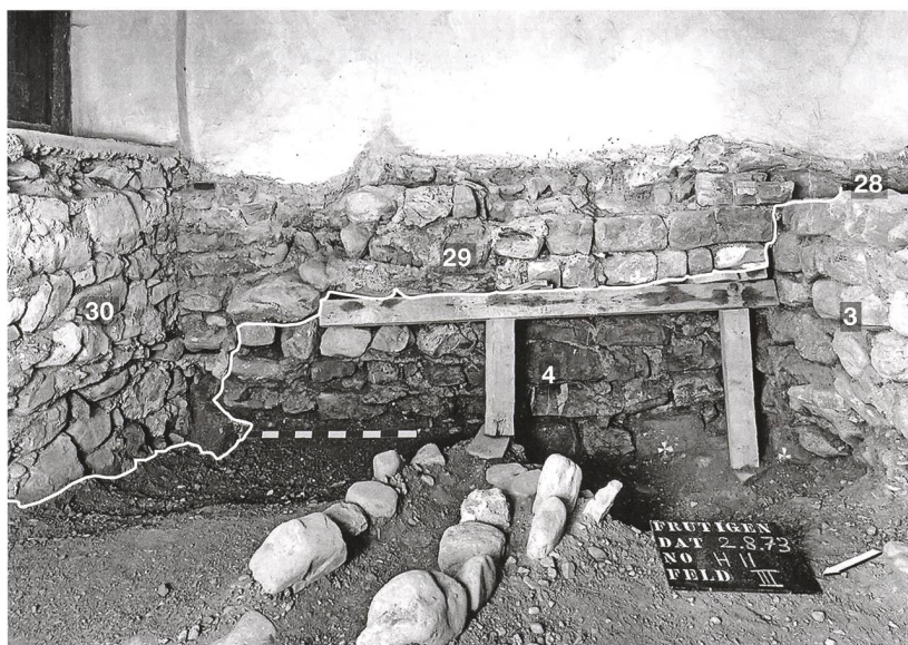
Abb. 14: Frutigen, Kirche. Ansicht an die nördliche Schultermauer des Schiffes (Tagebuchs-kizze und Foto). Unter der vorragenden Schultermauer von 1727 (29) liegt das ältere gerade Mauerstück (4). Blick nach Osten. M. ca. 1:50.
