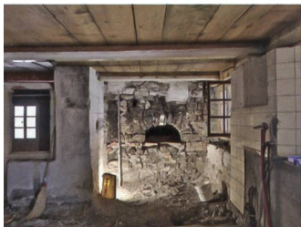
94 Reichenbach i. Kandertal, Kientalstrasse 12
