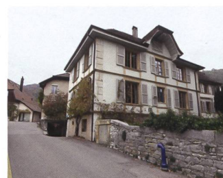
78 La Neuveville, Route du Château 19
