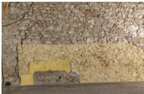
10 Biel, General-Dufour-Strasse 22. Erdgeschoss des Schulhauses. Gelb: Mauer 4 der Johanniterkommende mit Kielbogen (rechts) aus dem 15. Jahrhundert. Blick nach Nordosten.
