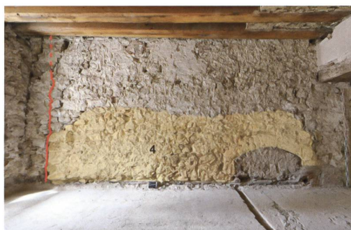
3 Biel, General-Dufour-Strasse 22. Erdgeschoss des Schulhauses. Rot: Negativ der Stadtmauer, 14. Jahrhundert; gelb: Mauer 4 der Johanniterkommende, 15. Jahrhundert. Blick nach Südwesten.
