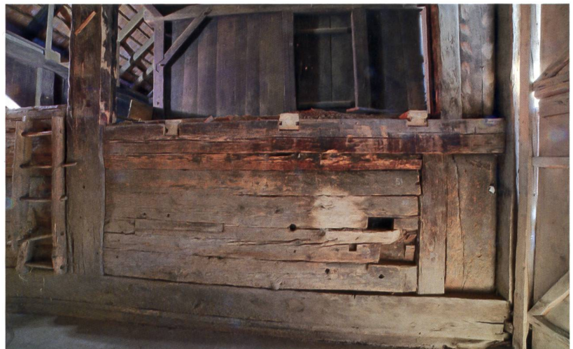
4 Schwarzenburg, Albligen Mischleren 96. Blick an die Wand zwischen Tenn und Wohnteil (QB II). Die ehemals bis oben geschlossene Wand besteht im unteren Teil aus liegenden und einzelnen stehenden Bohlen. Die fehlenden Bohlen auf Gadenhöhe ermöglichen die Sicht auf die Binnentüre zum Gaden R10. Blick nach Südosten.
