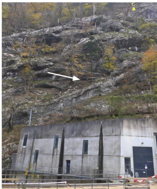
21 Péry-La Heutte, Grotte Électrique. Vue de la paroi rocheuse située au-dessus de la centrale hydro-électrique de Rondchâtel. On devine le porche de la grotte au milieu de la photo (flèche ; novembre 2022).
