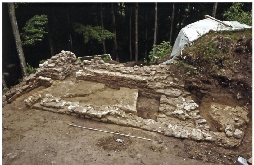
6 Melchnau, Grünenberg. Auf dem Bild ist die Grabungsfläche beim grossen Turm zu sehen. Blick nach Nordwesten. Aufnahme von 1995.
