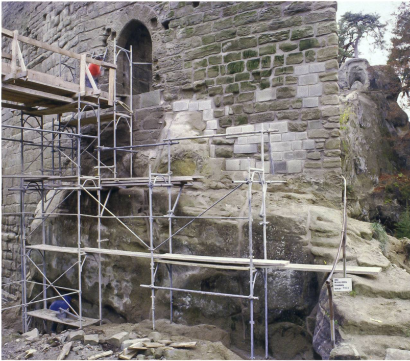
10 Schwarzenburg, Grasburg. Ostmauer vom Palas mit ersetzten Sandsteinquadern. Blick nach Südwesten. Aufnahme von 1984.
