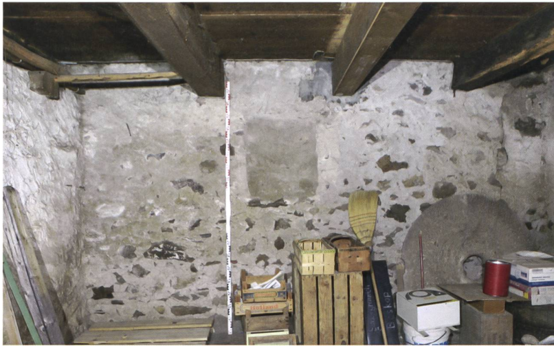
19 Thun, Schorenstrasse 40. Blick auf die nordöstliche Aussenwand (144) des Kellerstockes (Raum 11) mit der zuge-setzten Lichtnische (148). Auf den Deckenbalken ruhen die Trägerbohlen eines Kalkgussbodens (147).
