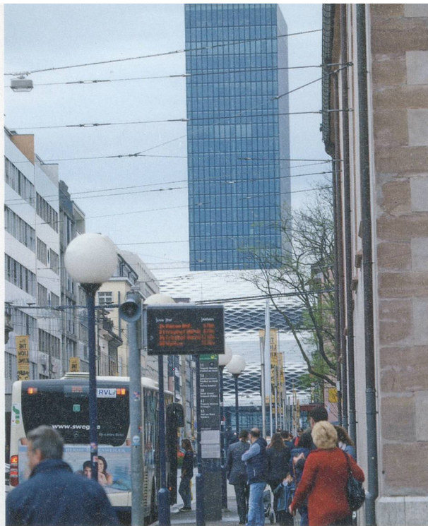
Bild rechts oben An bester Lage mit Aussicht über die Stadt: ein Parkhaus für 1200 Blechkarossen
