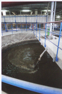
Mit der neuen Anlage können in Zukunft auch Stickstoffe aus dem Abwasser eliminiert werden.
