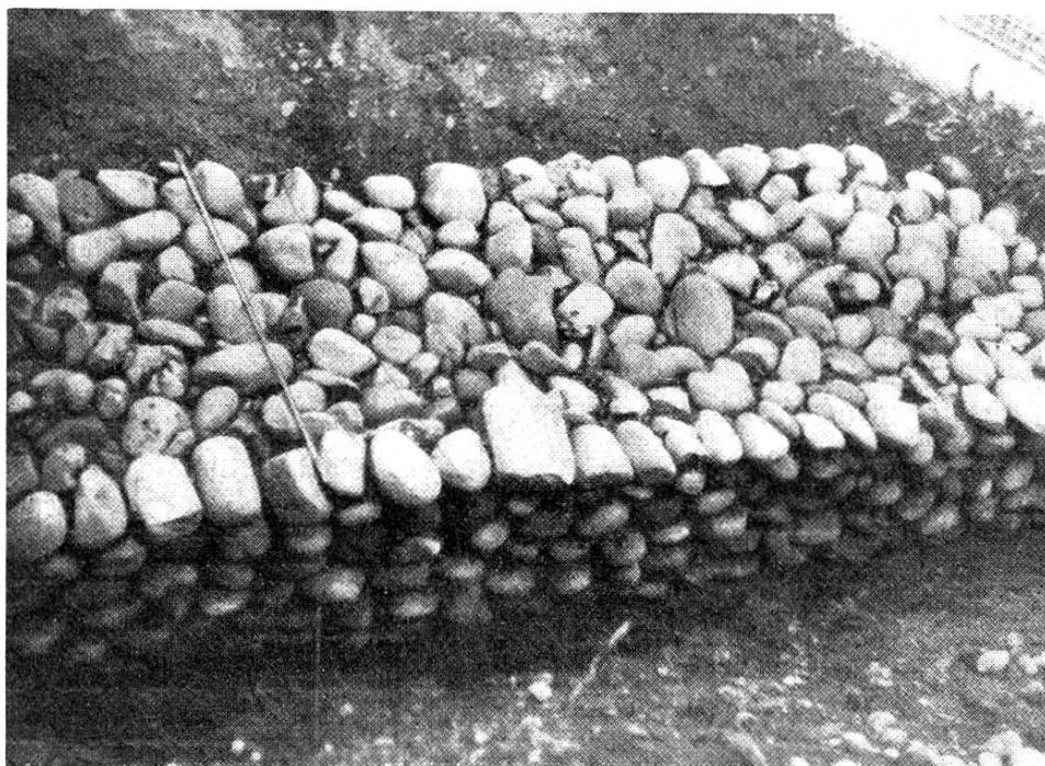
Mauerfundament aus Kollblöcken und Haussteinen, mit Mörtel verbunden, gefunden beim Numattenfriedhof, Oktober 1934
