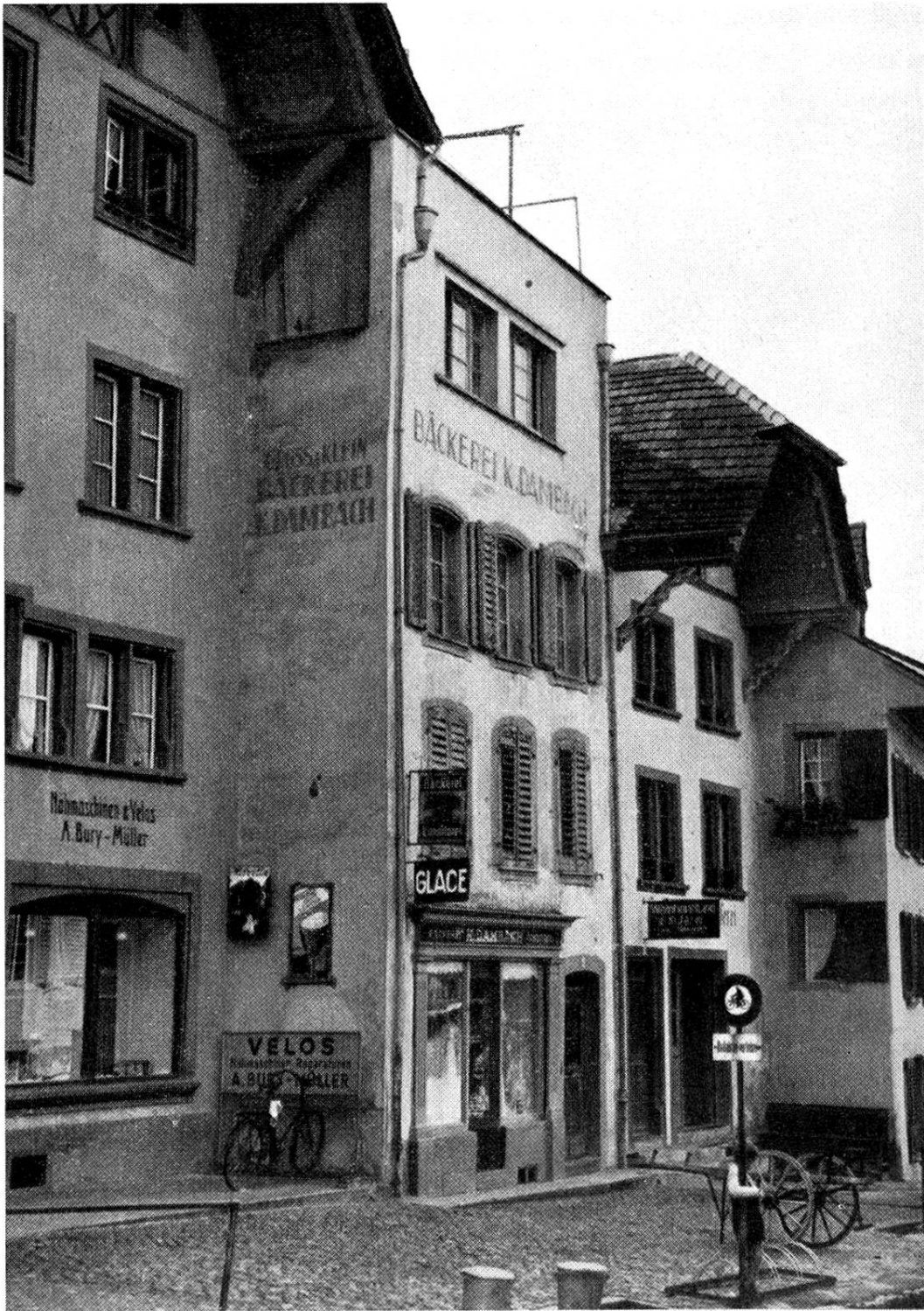
Unschön ausgeführte Aufstocfungen ...
