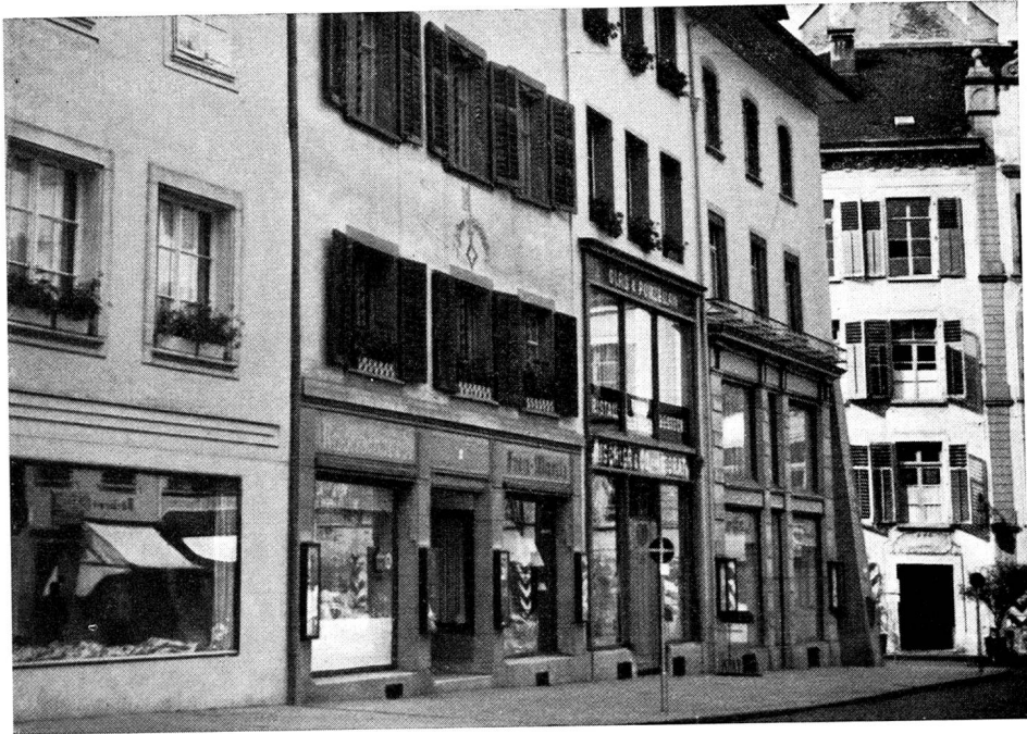
Um die Jahrhundertwende wurde mit den durch zwei Stockwerke reichenden Schaufensterfronten in schlimmer Weise den alten Häusern der Bauch aufgerissen
