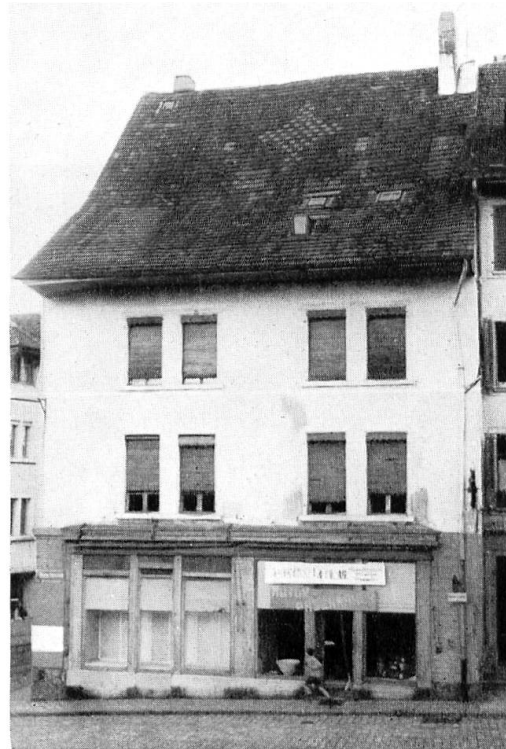
Das «Wolleb-Haus» vor dem Abbruch 1958, als unterstes Gebäude der Oberen Vorstadt ursprünglich Geleitshaus, 1805–1859 Postamt (siehe Bild links).
