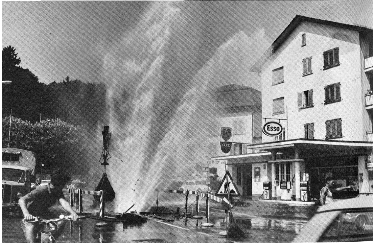
Konkurrenz zum AEW-Springbrunnen in Aarau: Eine geplatze Wasserleitung an der Küttigerstrasse
