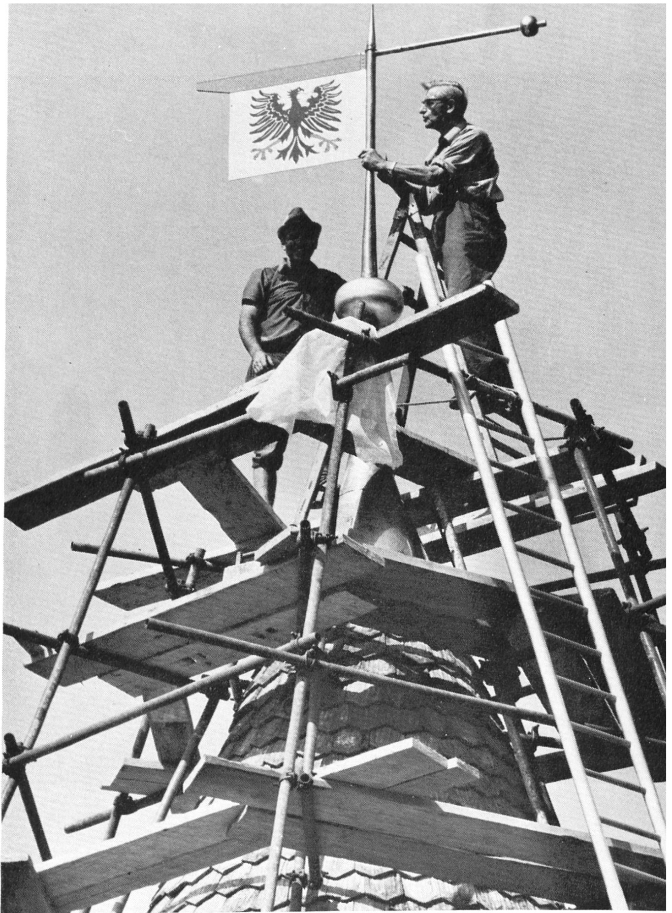
Der renovierte Pulverturm erhielt einen hübschen Hut, auf den die Aarauer Fahne aufgesetzt wurde
