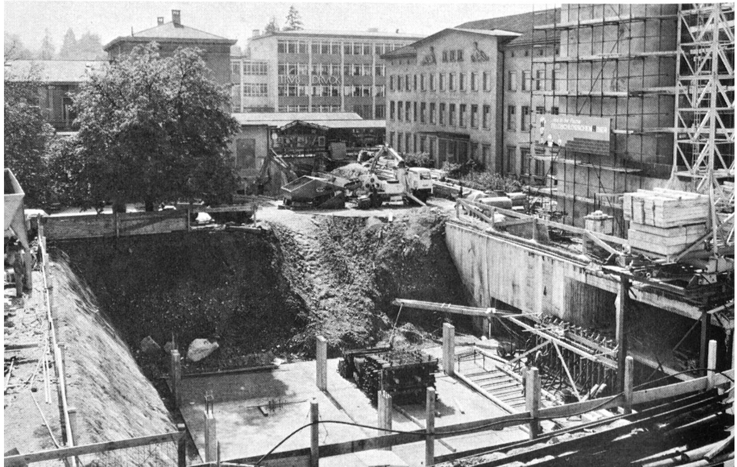
Auf dem ehemaligen Bahnhofplatz werden gewaltige bauliche Veränderungen vorgenommen. Die zweigeschossige unterirdische Sammelgarage wird ihre Fortsetzung unter dem neuen Aarauerhof finden, und zwischen dem Bahnhof und dem Gebäude der Bankgesellschaft wird am Westrand des Platzes eine weitere Fussgängerpassage errichtet.
