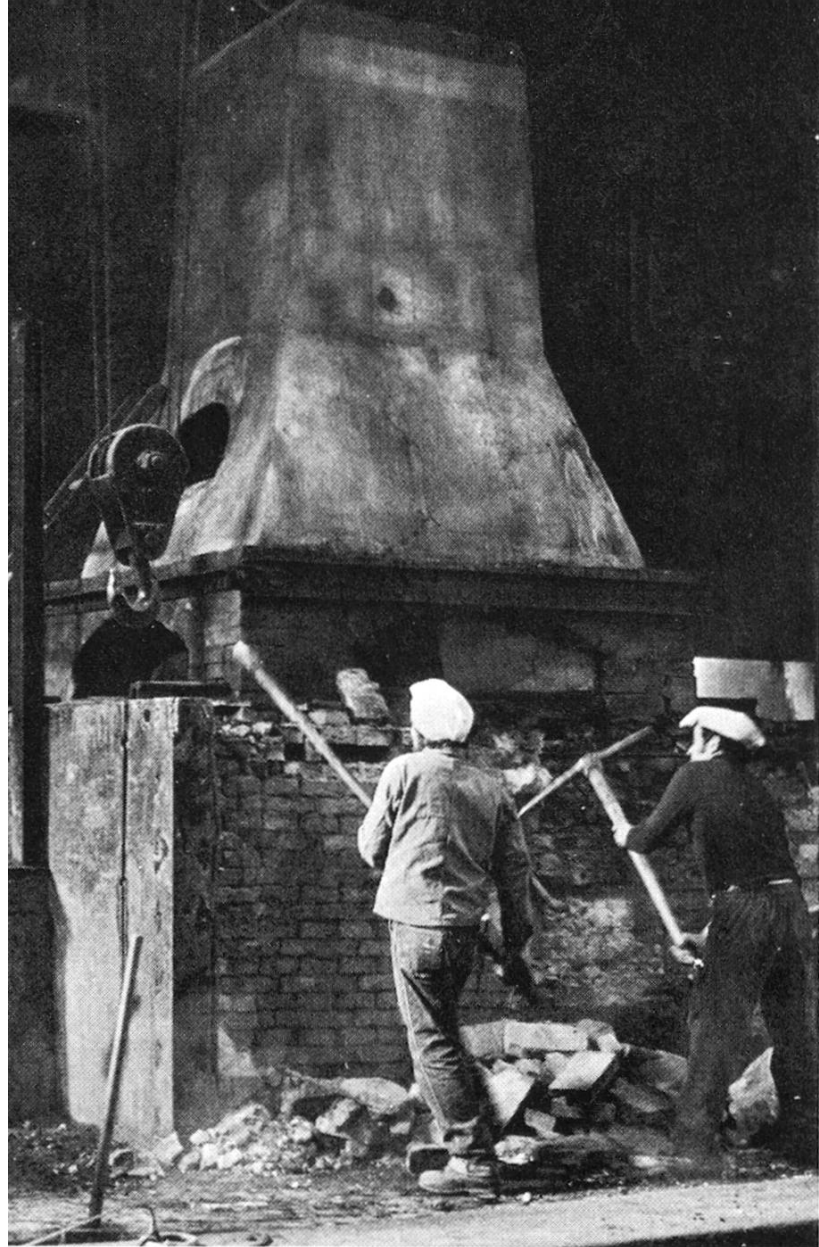
In der Glockengiesserei wird der letzte Holzgeheizte Giessoßen abgebrochen.
