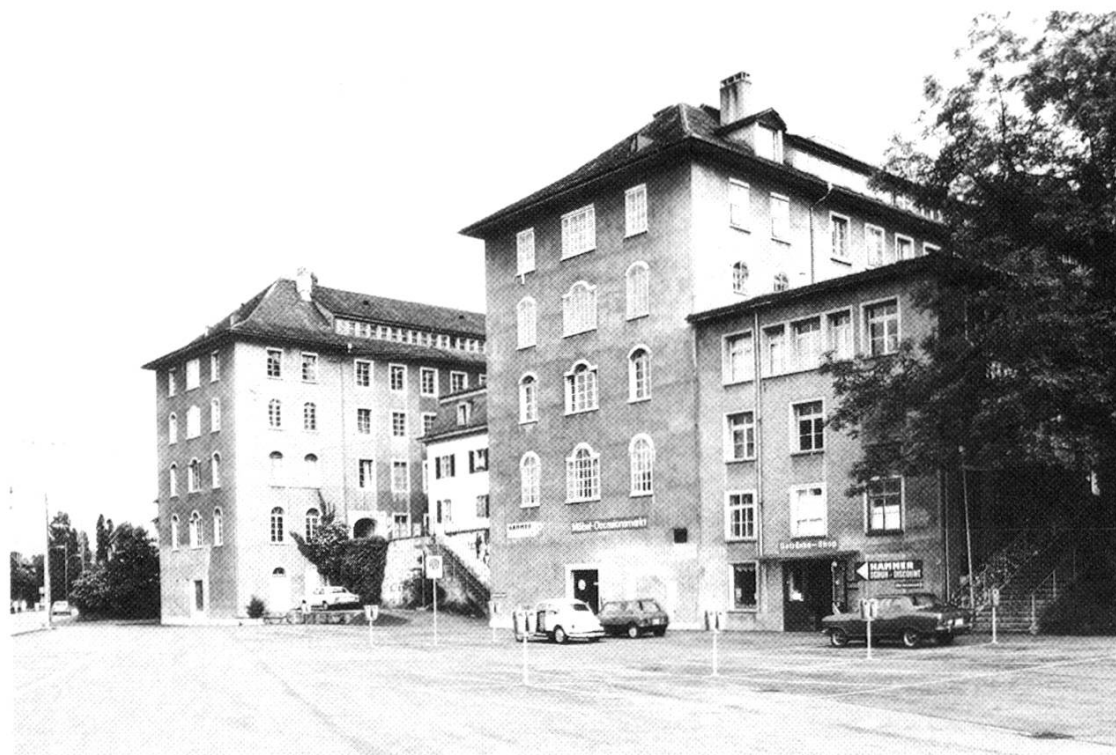
Die zur Seidenbandweberei Feer + Cie umgebaute und erweiterte ehemalige Indiennesdruckerei Herosé. Aufnahme 1980 vom Autor
