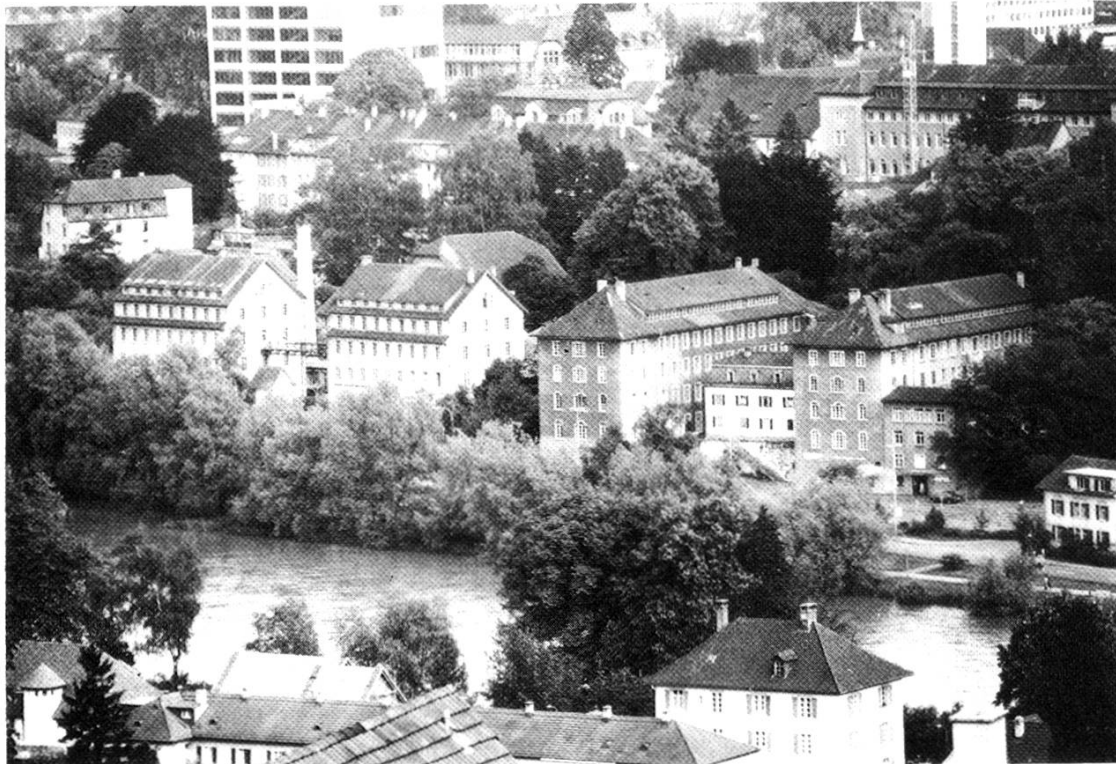
Ehemalige Indiennesdruckerei Herosé (1823/24), ganz rechts; Seidenbandweberei Feer + Cie (1853–1857), zweite von rechts; und ehemalige Zwirnerei und Färberei von J.G. Hunziker (1828/29), die beiden Gebäude links; ehemalige Bandweberei Hotze (1829/30), links hinten. Aufnahme 1980 vom Autor
