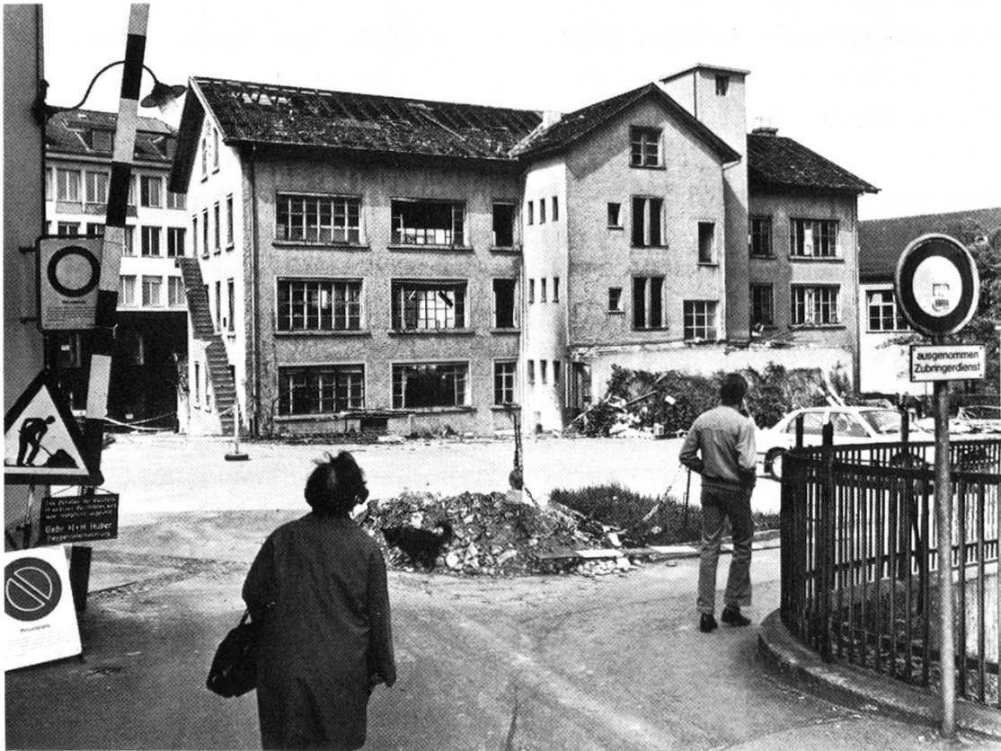
Abgerissen: die alte Fretz-Fabrik im Behmen
