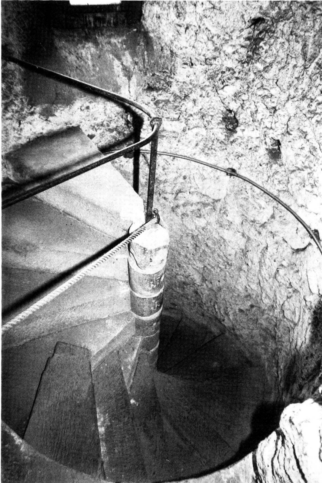
Oberes Ende der Wendeltreppe im 6. Geschoss
