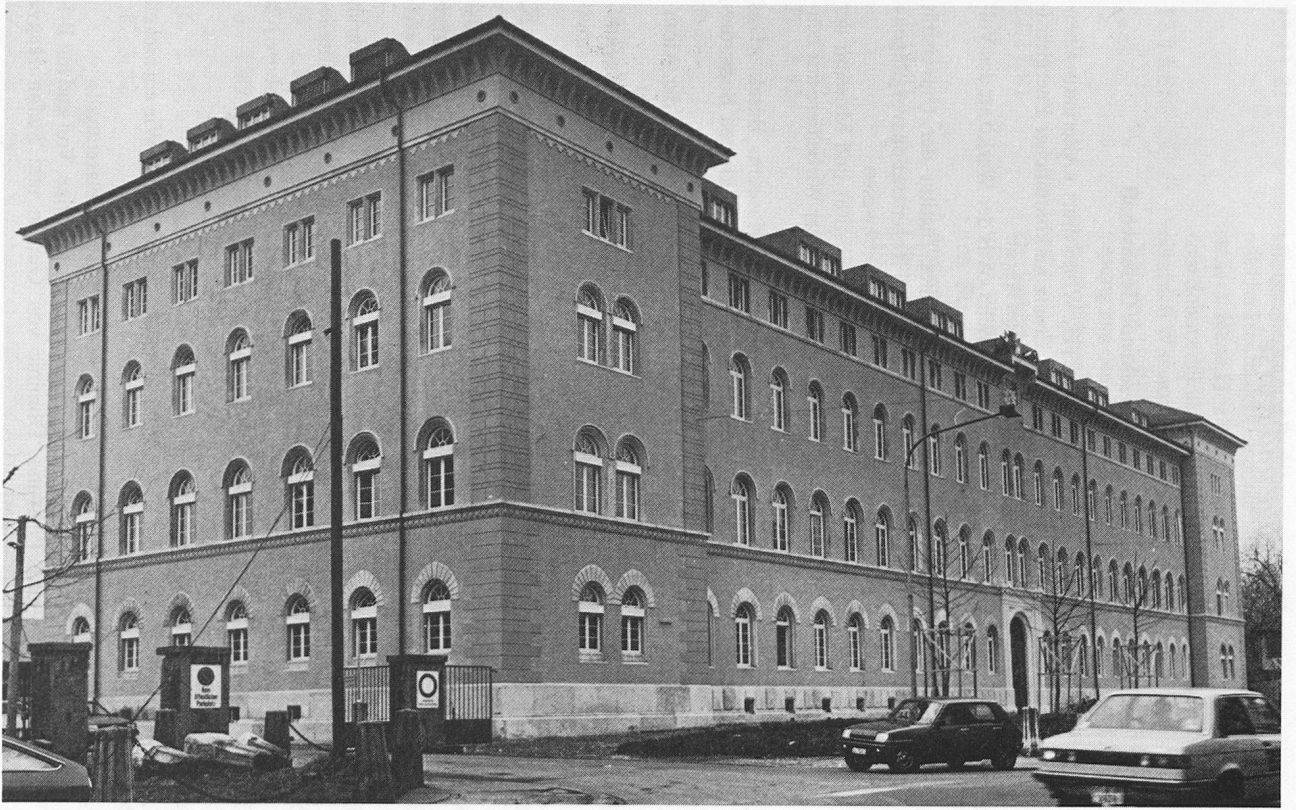
Erstrahlt in neuem Glanz: die renovierte Aarauer Infanteriekaserne
