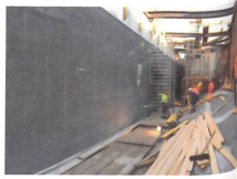
Die horizontal gerichteten Lamellen erzeugen eine für die Stromproduktion und die Lenkung von Fischen optimale Strömung. (Foto: Thomas Stucki)
