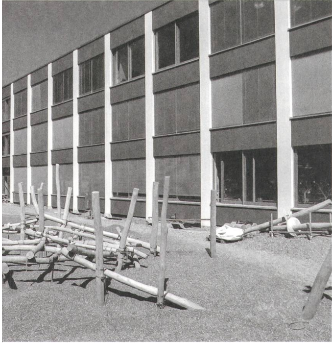
↑ Ansicht Süd mit dem Anbau, 2019. (Foto: George Pfiffner)
