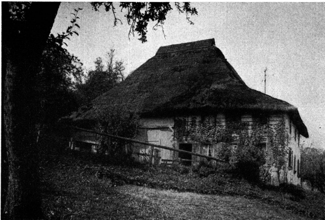
Bild 26. Strohdachhaus in Zuzgen (No. 76) mit Anbau. Rebspalier. Zustand vor 1925. Umdeckung mit Ziegeln, Kaminbau. (Phot. Vosseler)
