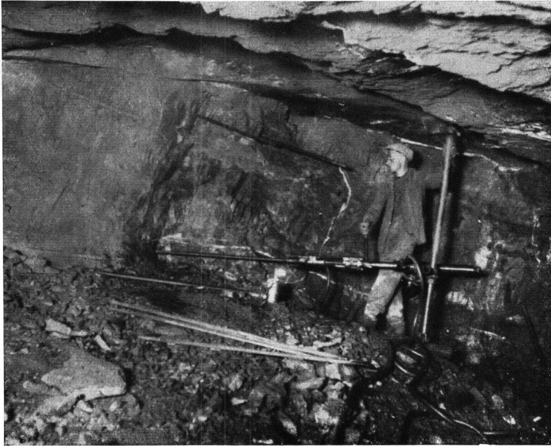
Gonzen: Bohrmaschine im Erzabbau
