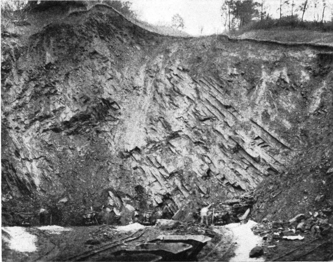
Abb.6. Bruch im Opalinuston der Tonwarenfabrik Holderbank. Die Steine werden durch Sprengen von der Wand gelöst
