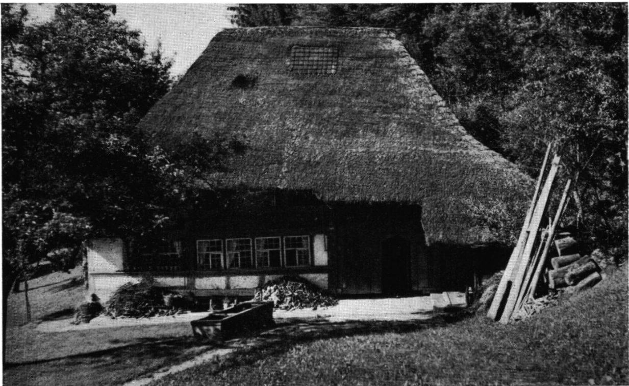
Abb. 9. Aargauerhaus, Seeberg ob Leimbach im Wynental. Dreisäßenhaus mit Wohnung (links), Tenn und Stall unter demselben steilen, strohbedeckten Walmdach. Das Dach besonders über dem Wohnteil etwas weniger weit heruntergezogen. Die beiden Fensterreihen gehören zu Stube und Stübli. Aus dem einfachen Aargauerhaus ist durch Weiterentwicklung das großartige Emmentalerhaus entstanden. Photo: Aargauische Kunstdenkmäler
