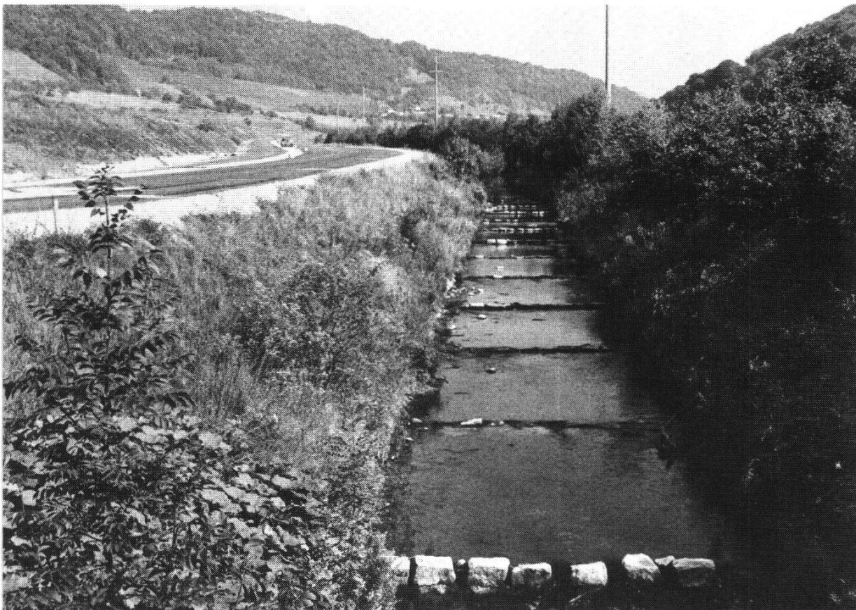
Abb. 7b: Begradigter, verbauter Bach. Sisselbach, Gemeinde Hornussen, direkt oberhalb Roggenmoos. Der beim Autobahnbau verlegte Bach ist mit einheitlichem, trapezförmigem Querprofil angelegt; die Ufer sind durchgehend mit Steinen befestigt; das Gefälle wird mit Schwellen in exakt regelmäßigen Abständen überbrückt. Wasseramsel und Bergstelze finden in diesem eintönigen Gewässer keine günstigen Lebensbedingungen. Foto H. Leuzinger, Rheinfelden.
