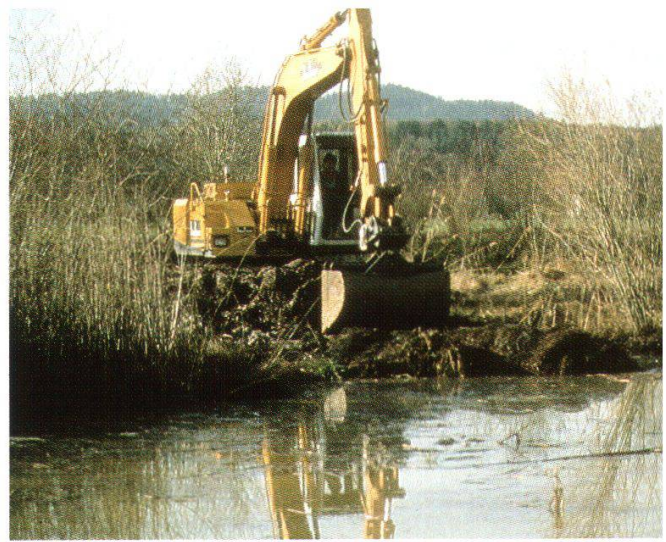
Abb. 11: Die Umsetzung dieses Amphibienschutzkonzeptes bedeutet in vielen Fällen ein periodischer Einsatz mit Trax und Bagger.
