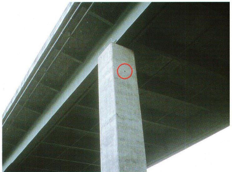
Abb. 7: Autobahnviadukt über die Reuss zwischen Birmenstorf und Mülligen; in jedem Pfeiler befindet sich ein Fledermausquartier. Das Lüftungslöcher, welches als Ein-/Ausflug benutzt wird, ist rot markiert.
