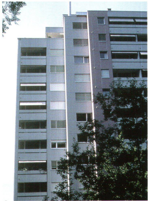
Abb. 1: Das ursprüngliche Fledermausquartier befand sich vor der Renovation im Rolladenkasten des obersten linken Fensters. Als Ersatz wurde ein kleiner (rechts) und ein grosser (links) Fledermauskasten auf dem Dach befestigt.
