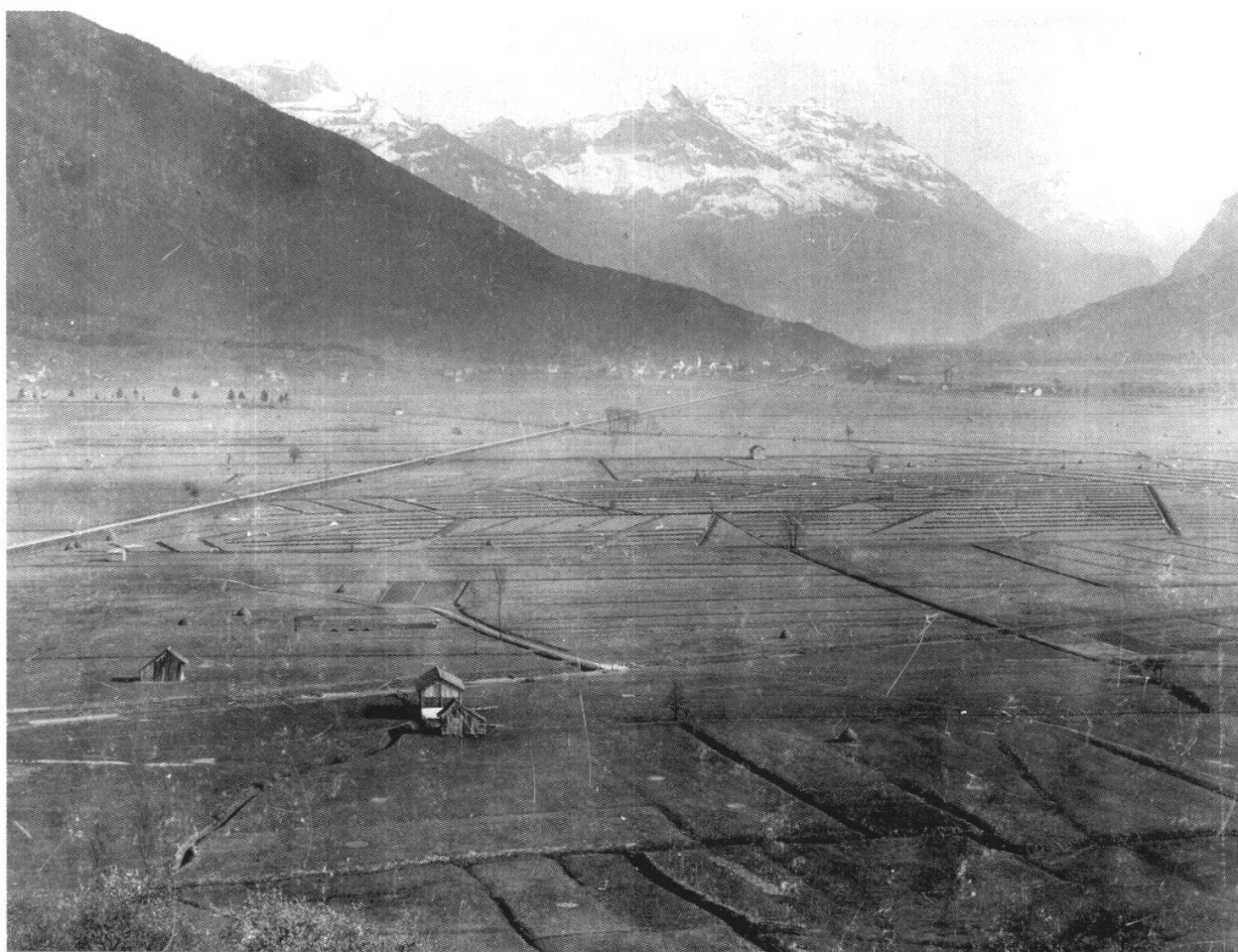
Abb. 7: Blick vom oberen Buchberg über die Gross-Gastermatt Richtung Schänis (um 1890/1900, ohne Autor, StA SG). Deutlich zu erkennen ist das ausgeprägte Grabennetz.
