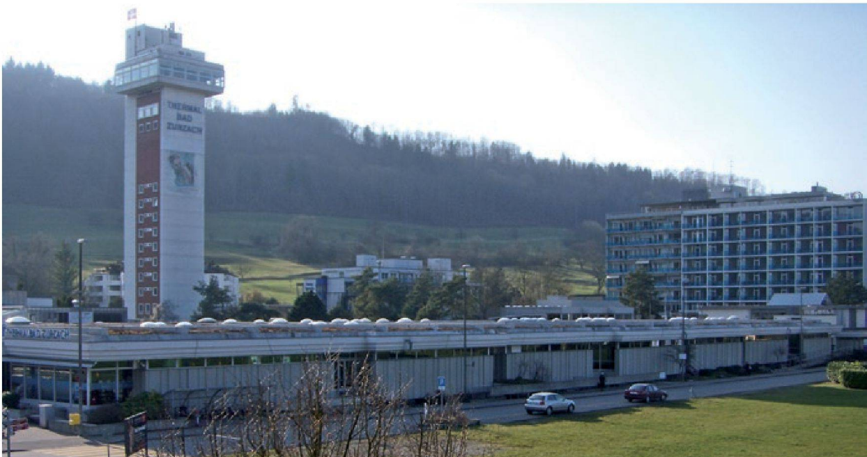
Abb. 9: Ansicht Bad Zuzach, Thermalbad. Der 1963 erbaute Turm ermöglicht die Druckregulierung des ausfliessenden Thermalwassers
