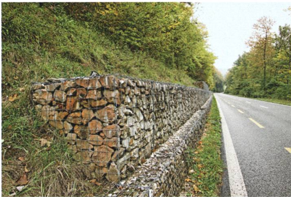
Abb. 2: Gabionen, Steinkörbe entlang einer stark frequentierten Strasse.
