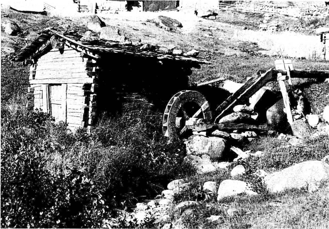
Vegl fallun da Fuorns cun roda zanistrera, canals alla moda veglia e pala da sclauder. Fotografia da Meisser 1910. Negativ tier Tgira da monuments, Cuera.
